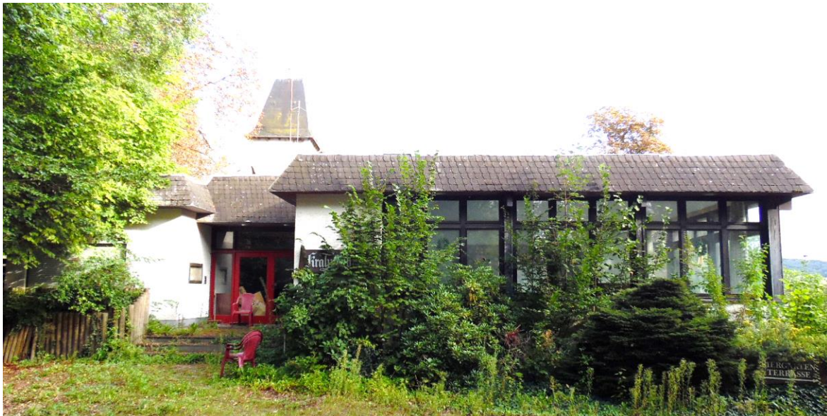
Abbildung 1: Zustand der Bausubstanz im Frühjahr 2019
