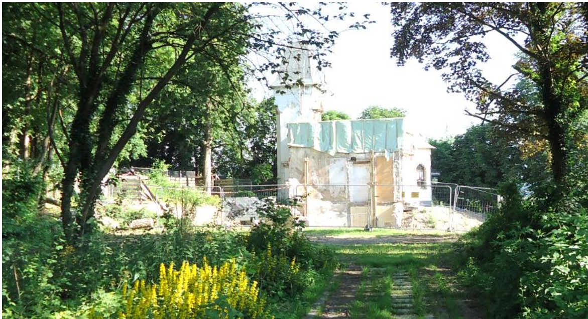
Abbildung 2: Zustand des Geländes nach den Rückbauarbeiten (Juni 2019)
