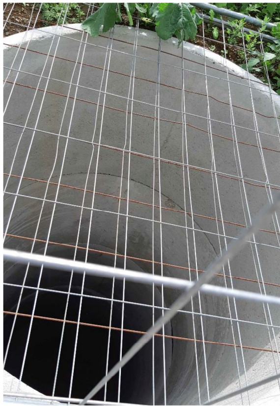
Foto 1: Bestehendes Schachtbauwerk im Tiefpunkt
